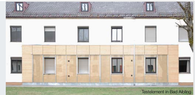
Testelement in Bad Aibling
